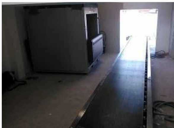
Estado que se encontró la unidad
