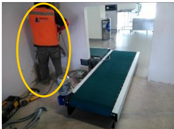
Trabajos realizados cuando llegamos al lugar de trabajo
