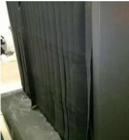
Instalación de cortinas plomadas
