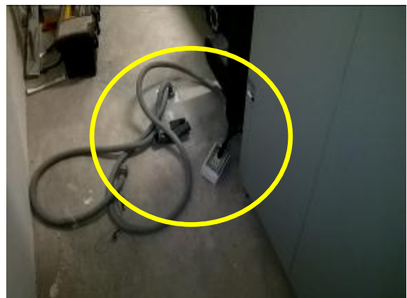
Conexión de la unidad a la única toma disponible con 211VAC
