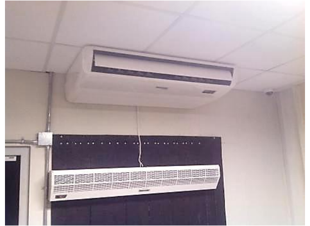
Cortinas de Aire (COR+A y COR+B); Split de aire (A.C.+A) instalados
