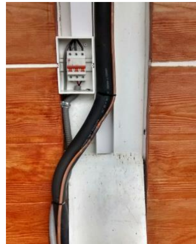
Bajadas de fuerza (220/3/60), control (24V) y refrigeración (R22)
