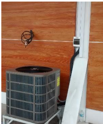
Instalación final del compresor (Circuito de protección y bajadas conforme a estructura arquitectónica)
