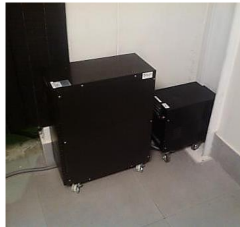
Trabajos de recableado para reubicación de UPS y Transformador (Circuito individualizado de tablero principal)
