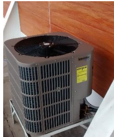
Instalación final del compresor (Circuito de protección y bajadas conforme a estructura arquitectónica)
