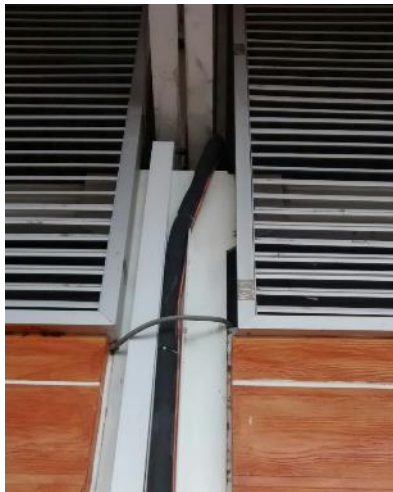
Bajadas de fuerza (220/3/60), control (24V) y refrigeración (R22)
