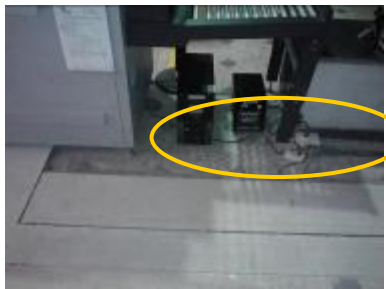
Cables expuestos
