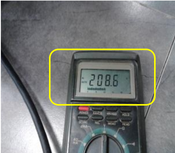
Entrada suministro eléctrico MQRX (19:15)
