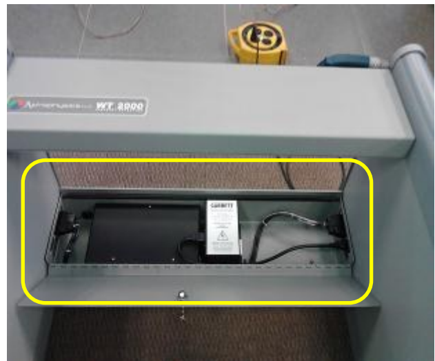
Limpieza interna cableado y verificación F.A.
