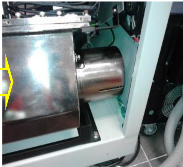
Limpieza, verificación de cableado y conectores
