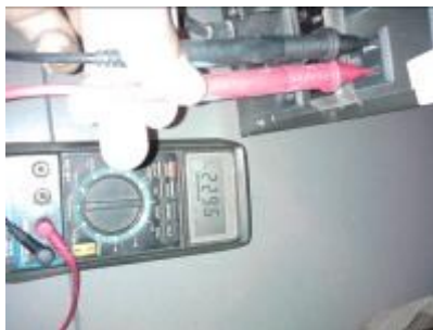
Verificación de suministro eléctrico
