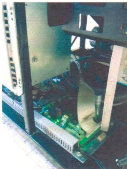
Mantenimiento interno realizado
