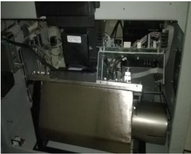
Comprobación de estado de Tanque
