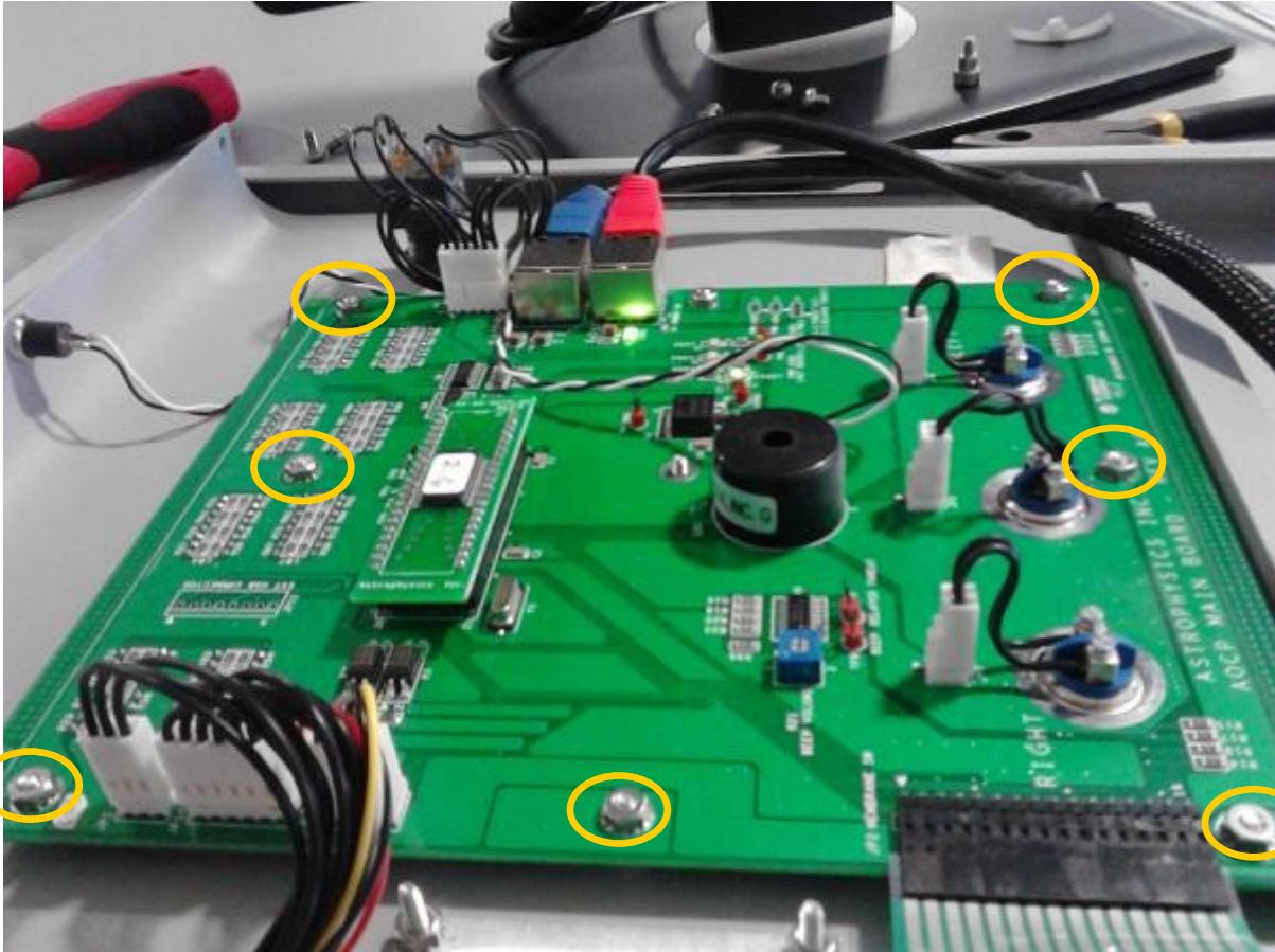
Tarjeta electrónica de la AACP la cual se le colocaron sus tuercas respectivas y fueron ajustadas .
