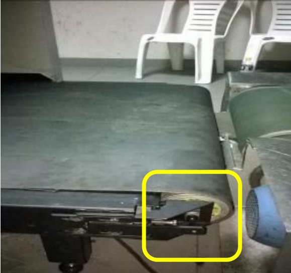
Colocación de motor en unidad
