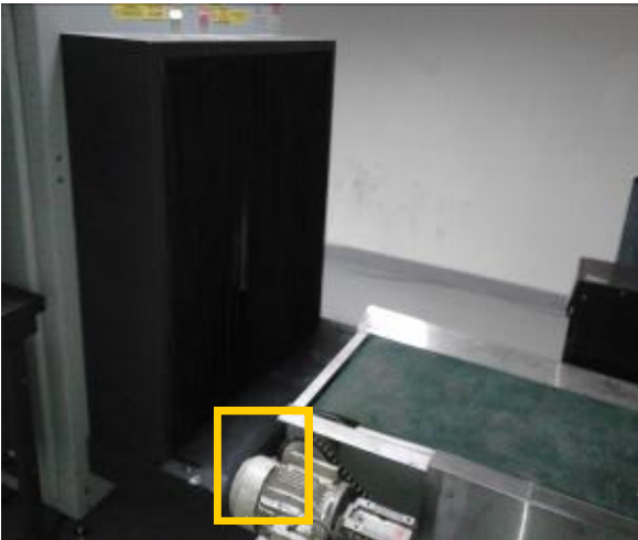
Colocación de cortinas plomadas entrada/salida
