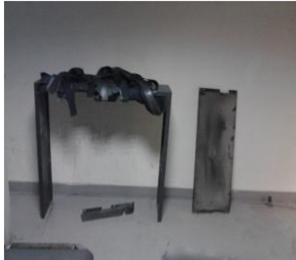
Retiro de cortinas plomadas entrada/salida
